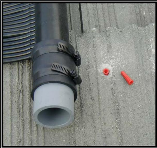
2. Una ancla de plástico será insertada en el hoyo será usada para asegurar la tira del manifold.
