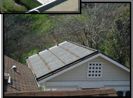
Este sistema fue instalado en un techo nuevo de composición. Trabajamos con el trabajador del techo para tener dos 20' 2x4s sellado debajo de la lamina para mejor seguridad contra goteras. Todas las correas serán atornilladas a estas.
