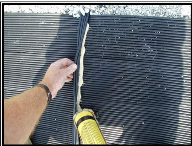
6. Añade una línea pequeña de adhesivo colector directamente debajo de las tiras esto mantendrá las tiras de los colectores de destensarse con el tiempo.
