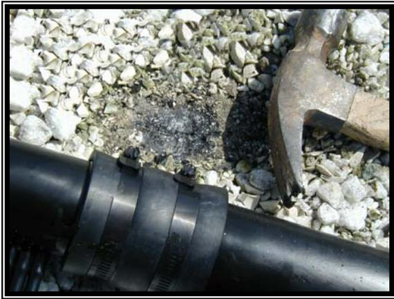
3. Después de que todos los manifolds estén seguros, desenrolle los colectores. Conecte y asegure los manifolds en la otra punta.
