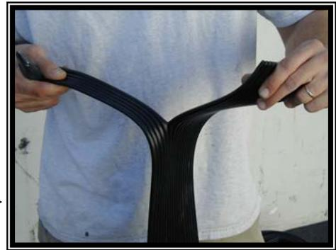
4. Usando el material de los colectores que se proporciona en el equipo de instalación, separe los tubos en grupos de cuatro para hacer las tiras de los colectores. Póngalos al otro lado de los colectores cada cuatro a cinco pies.
