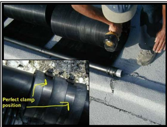
2. Sujete un adaptador a cada punta del manifold con un par de gomas y dos abrazaderas de acero.
