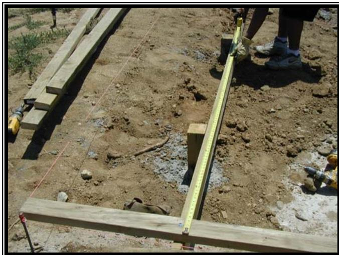
13. Sujete las vigas primero asegurándose que las puntas toquen la línea del hilo arriba. Estas vigas estarán donde el colector manifold sea seguro y con espacio de 6 pulgadas mas allá de la longitud del colector actual.
