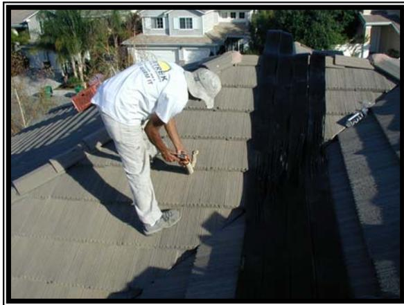
10. Empezando de la sección mas baja de la goma, volteé la sección al otro lado y córrala a lo largo de la otra sección del techo. Tenga extra cuidado para asegurarse que el colector permanezca en la misma altura del techo a como se envuelve en el techo.
