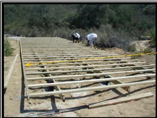
17. Usando 4" tornillos y rondanas, sujete 2"x4" en la punta de cada viga a lo largo de arriba y abajo.
