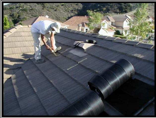
3. Desenrolle los colectores, pase la esquina, hasta que estén completamente desenrollados. Quite el tape. →
