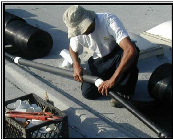
4. Este sistema tuvo que haber sido partido en dos bancos para que vayan alrededor de unas tragulces. Conecte el manifold con una pieza de pipa y dos 2' PVC couplings. Cuando haya determinado la longitud de la pipa necesitada, corte otra de la misma medida y péguela en un par de couplers y adaptares. Esto será usado para juntar la otra punta.
