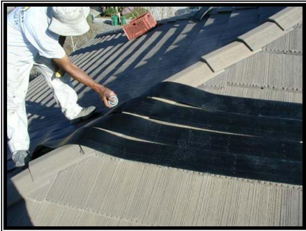
Use el mismo método para cortar el canal y voltear la esquina por la envoltura de afuera como lo hizo por adentro.
