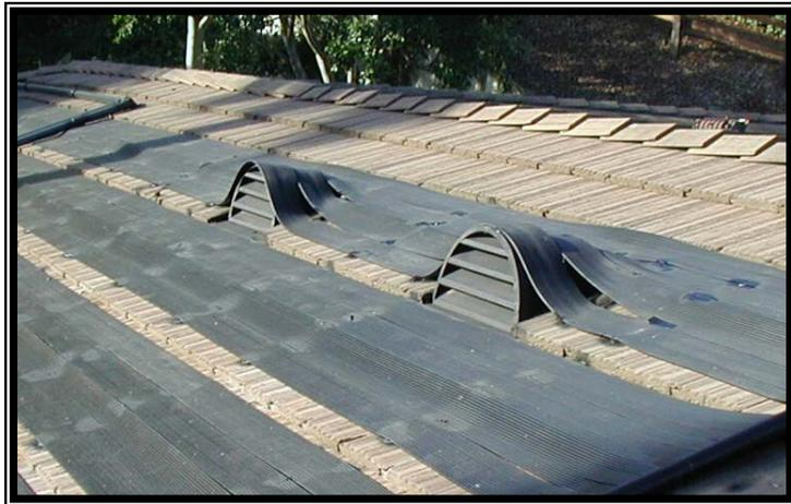
Cuando tenga que ir sobre estas ventanillas o respiradero o cualquier obstáculo sobre 18 pulgadas, necesita ordenar 1 pie de longitud del colector para cada obstáculo y ordene el colector con un manifold fuera. Esto le dará suficiente material para envolver alrededor de estos respiraderos y le mantendrá los manifolds alineados.
