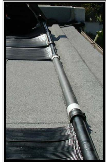
Instale la vacuum relief válvula a la esquina alta, en la punta del contrario de la pipa. →
