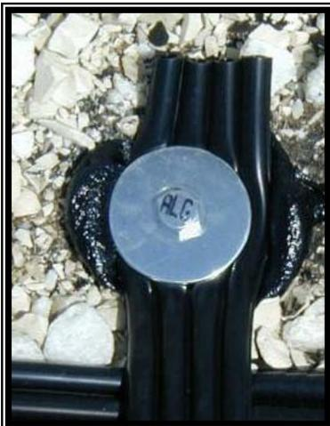
5. Cuando use tiras de tornillos, cuide de usar en abundancia el mastico de techo y no sobre apretar los tornillos. Si el tornillo gira en sitio, se sacara fácilmente y causara una gota potencial. Apriete lo suficiente para apretar la goma de la tira.
