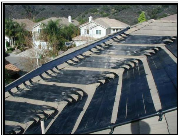
*Al usar la formación de zigzag par este trabajo, pudimos agregar 56 pies cuadrados de colectores mientras ahorramos el costo de 24 manifolds, 48 couplings, 96 abrazaderas, 48 tiras, 48 adaptadores de pipa, 90 fittings y como 50 pies de pipa.*
